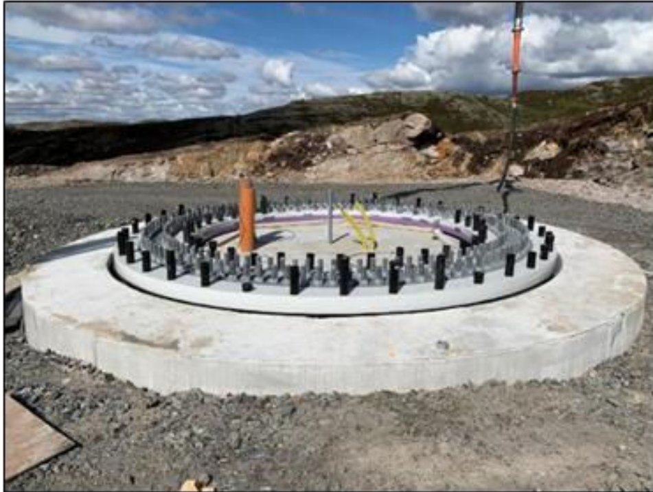
Figur 3-2: Turbinfundament i Tonstad vindkraftverk. Foto: Tonstad Vindpark AS
