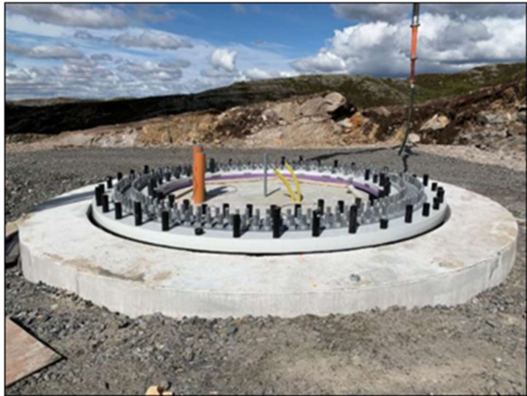
Figure 0-6: Turbinfundament og tårn i Tonstad vindkraftverk etter tilbakefylling av masse. Foto: Tonstad Vindpark AS
